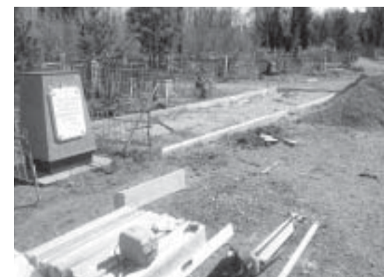
Ведутся работы по благоустройству памятного места.
